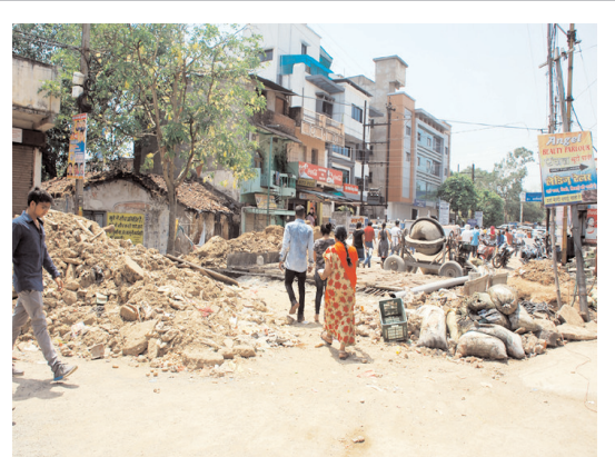
रायपुर, 13 मई। बैरन बाजार होलीकास स्कूल के पास नाला निर्माण कार्यों से आम नागरिकों को हो रही है परेशानी।
